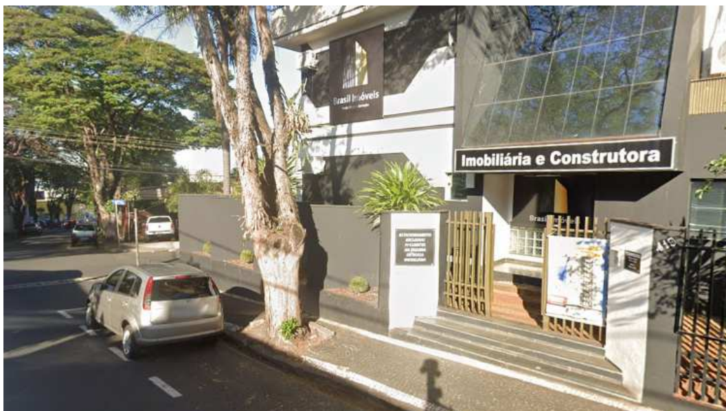
Figura 44 - Calçada obstruída por árvore Rua Primo Picoli, 419, Jd. Girassol
