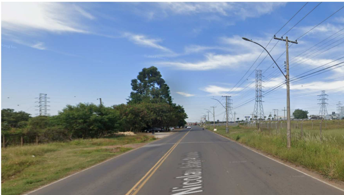
Figura 97 - Avenida Nicolau João Abdalla Fonte: Google Street View
