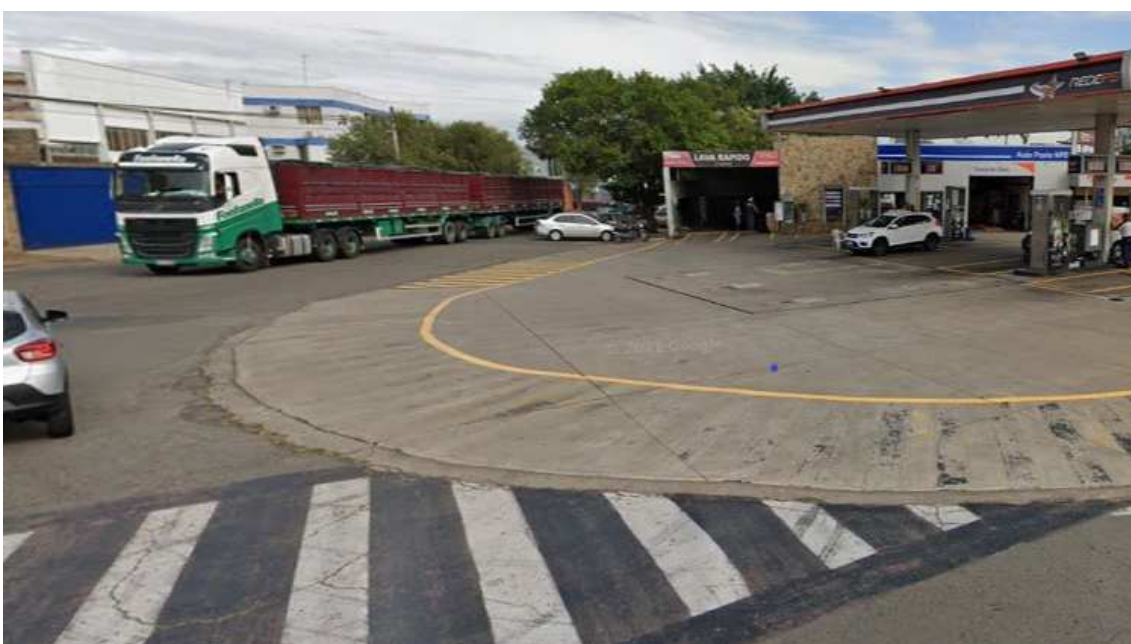
Figura 47 - Guia com extensão totalmente rebaixada para acesso de veículos ao posto de combustíveis.
