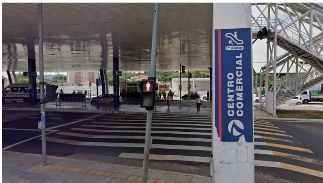
Figura 55 - Terminal Metropolitano Avenida Dr. Antônio Lobo, S/N, Centro
