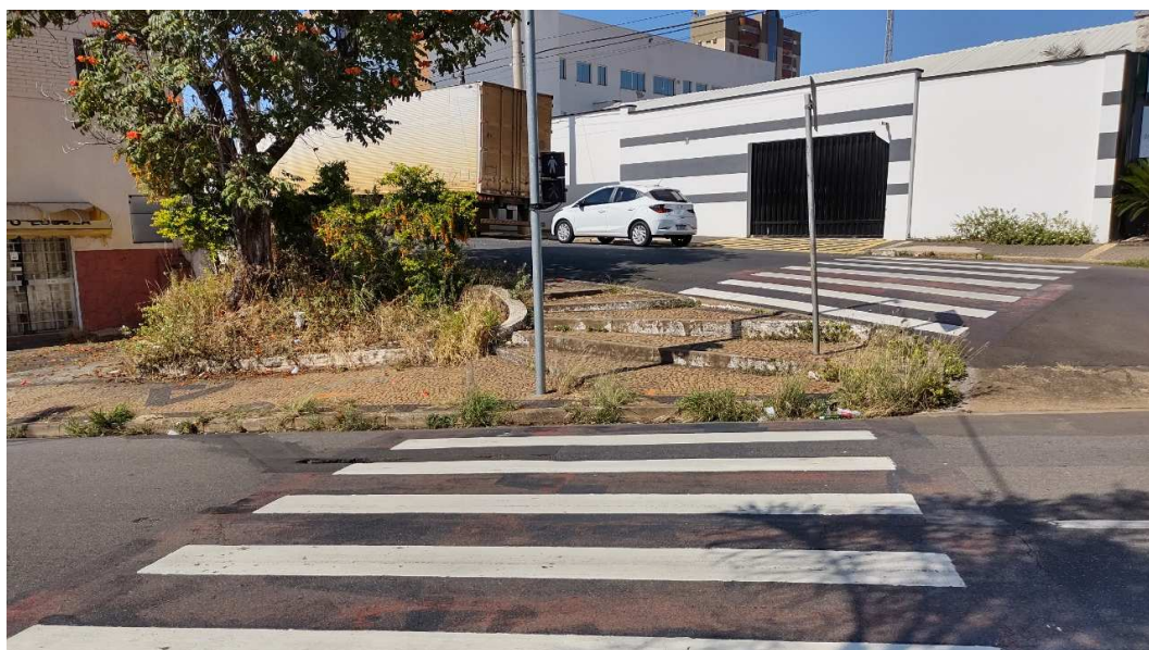
Figura 42 - Calçada com escada Avenida de Cillo, nº299, Vila Pavan
