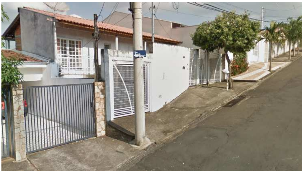
Figura 41 - Calçada com desnível transversal e degraus irregulares Rua Guarujá, nº 23, Jd. Primavera
