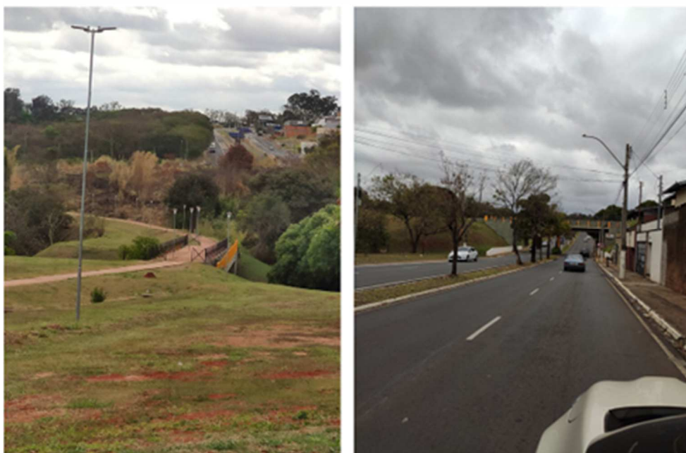
Figura 31 - Ciclovía dos trilhos em Santa Bárbara d'Oeste sobre o ramal ferroviário desativado
