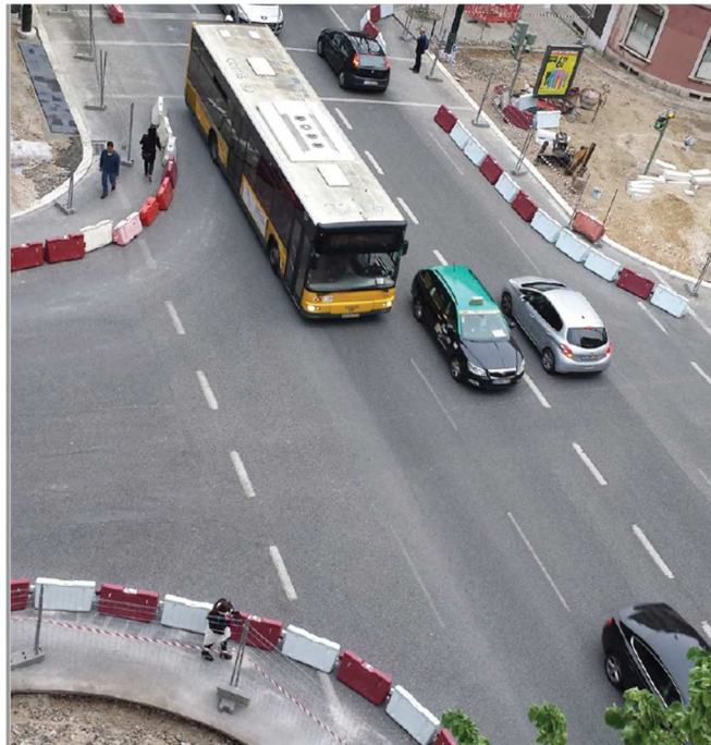
Figura 15 - Exemplo de deslocamento temporário de pedestres sobre o leito viário com proteção física
