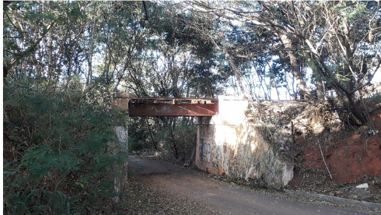
Figura 26 - Passagem sob linha férrea desativada - Vista da Rua Rio Claro
