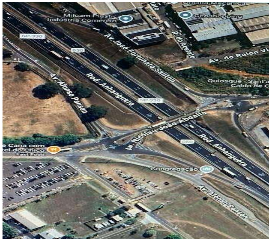
Rodovia Anhanguera, Avenida Afonso Pansan
