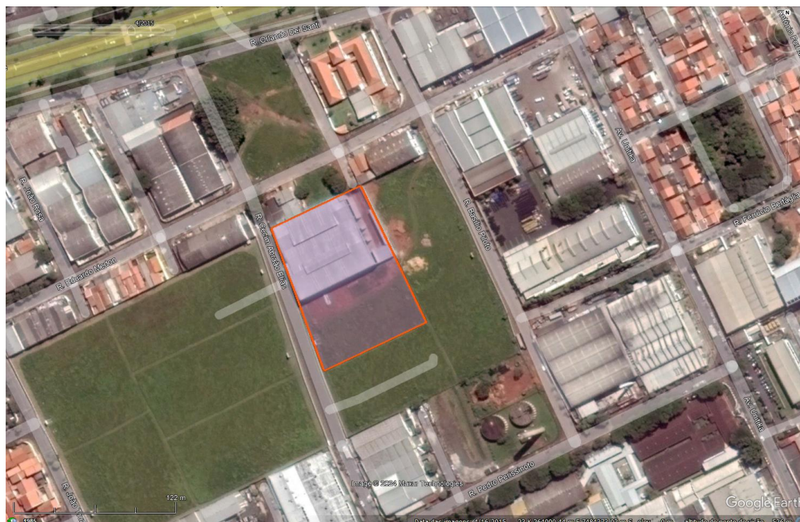
Figura 6. Foto aérea de Abril de 2015 nota-se a construção do Salão 1 concluído.
