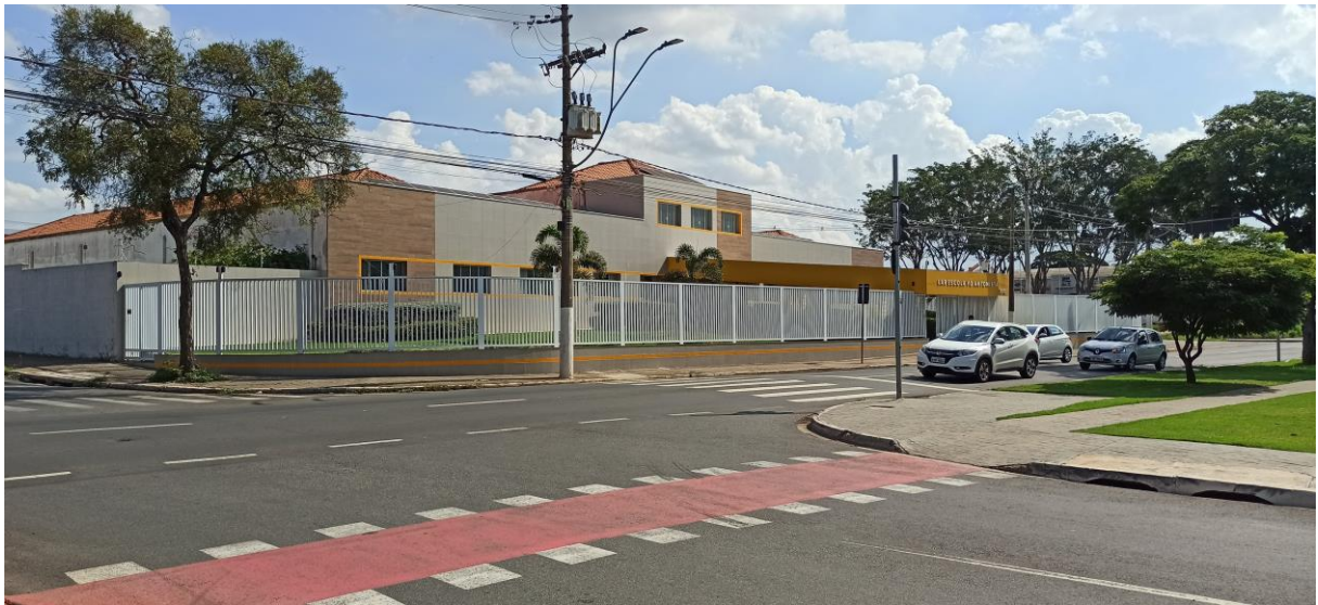
Figura 21. Aspecto do sistema viário remodelado no cruzamento da Rua Basílio Piloto e Rua Orlando Dei Santi. As obras realizadas trouxeram melhorias significativas para o trânsito local.
