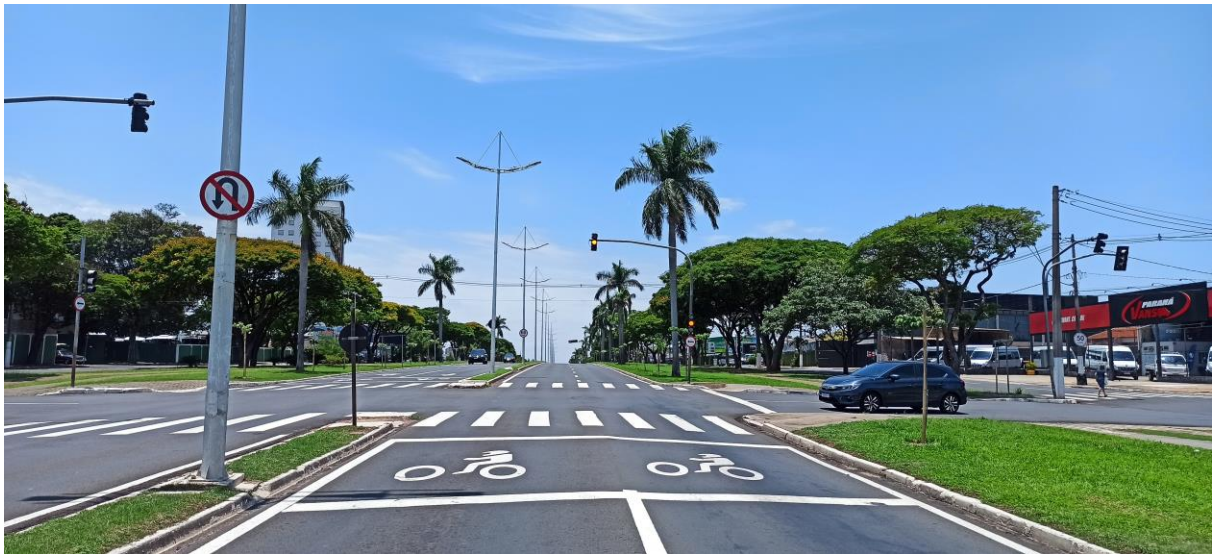
Figura 45. Avenida Antônio Pinto Duarte (Via arterial).
