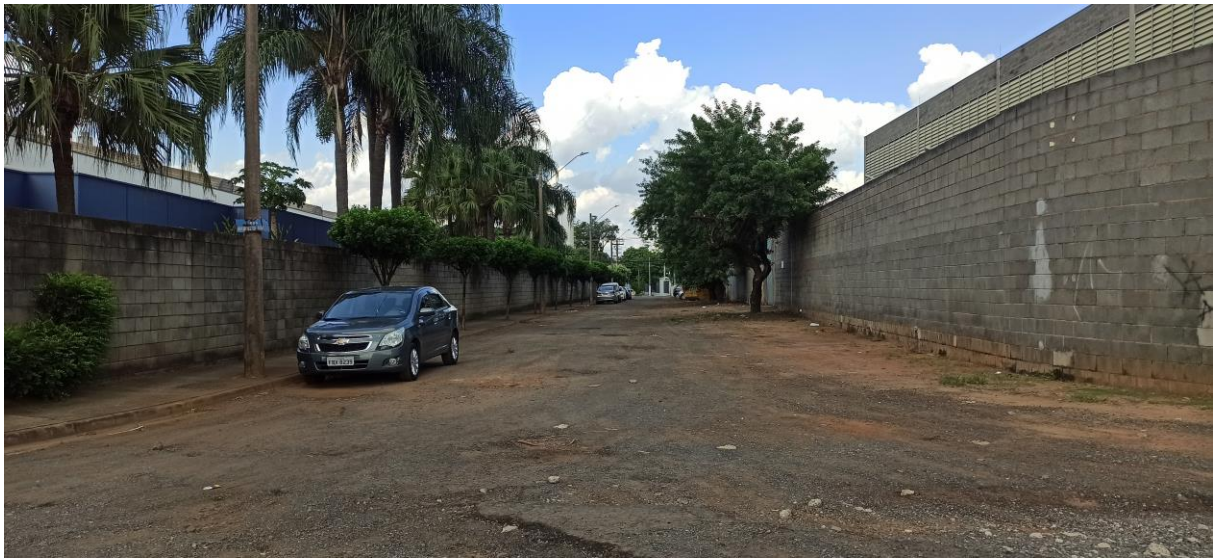
Figura 50. Aspecto da Rua Manoel Matos sem pavimentação.
