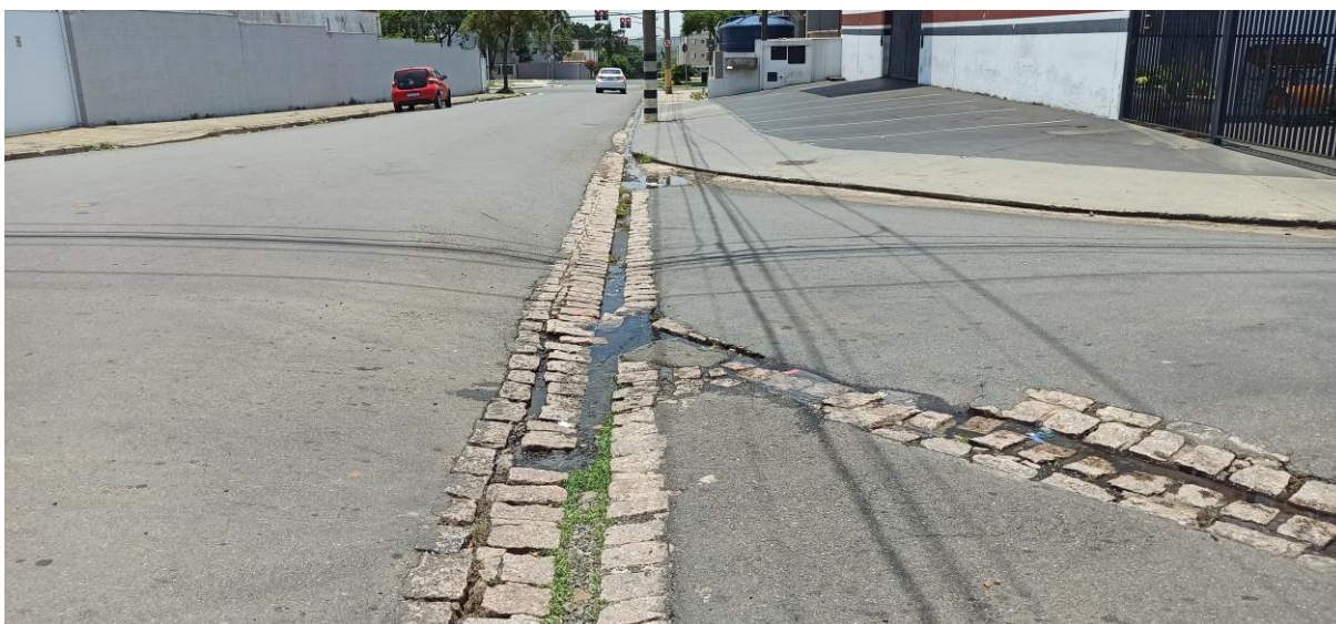
Figura 39. Aspecto de um sarjetão na área de Influência Indireta.
