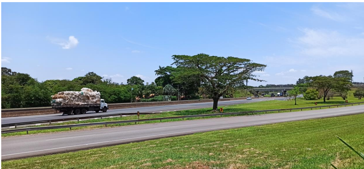
Figura 49. SP 330 – Rodovia Anhanguera Km 125 (Via Estrutural).
