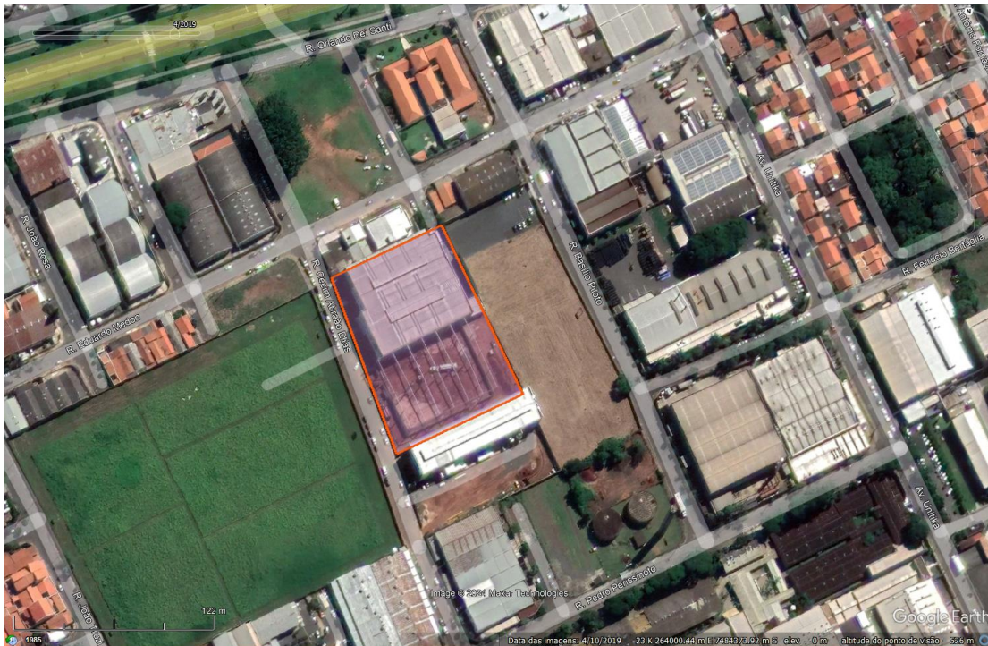
Figura 7. Foto aérea de Abril de 2019 nota-se o Salão 2 em construção.
