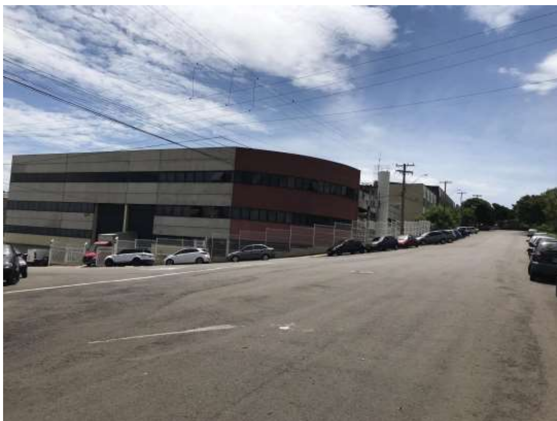
Figura 5 - Rua Djalma Rogerio corioni
