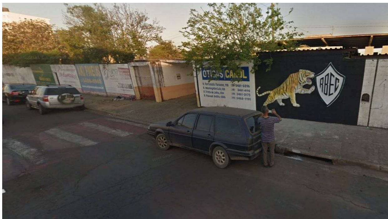
Figura 4 – Fachada frontal do Estádio Décio Vitta
