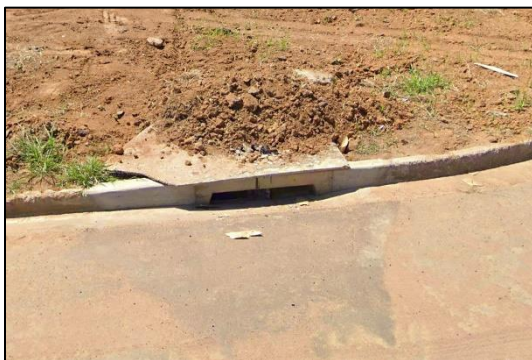
Sarjeta e boca de lobo
