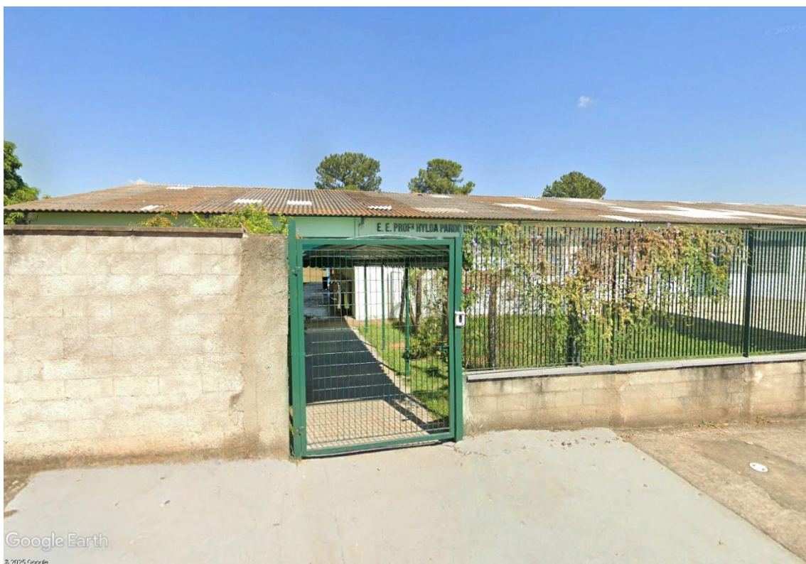
Figura 23. Área institucional localizada na AII.
