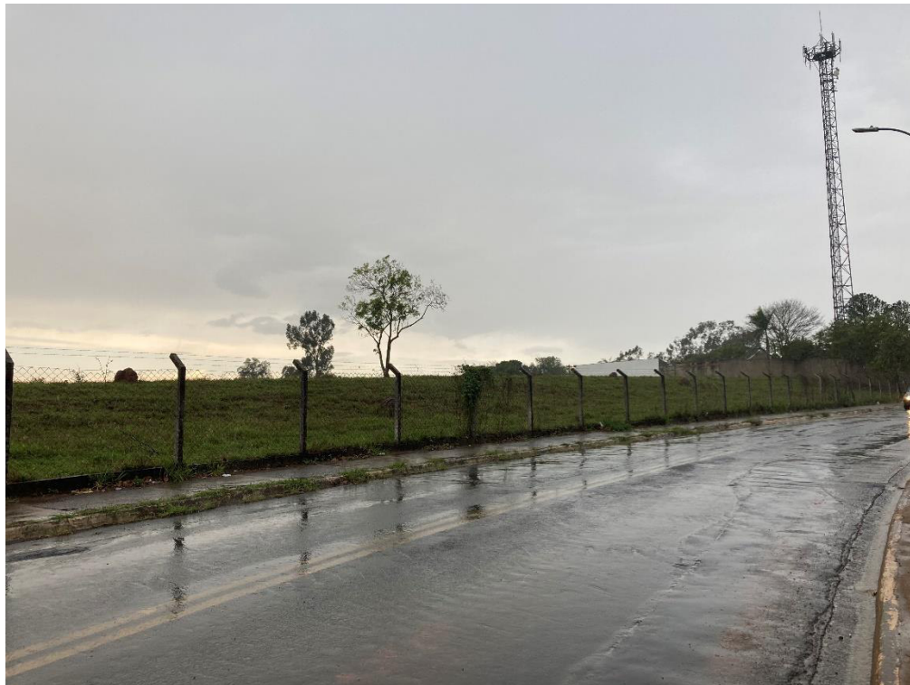
Figura 28. Vista da Avenida Heitor Siqueira.
