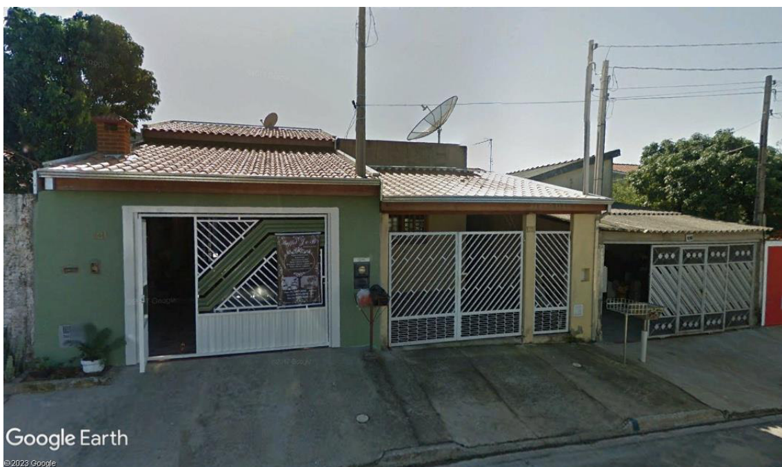
Figura 36. Residências unifamiliares localizadas na All – Rua Francisco Zago.
