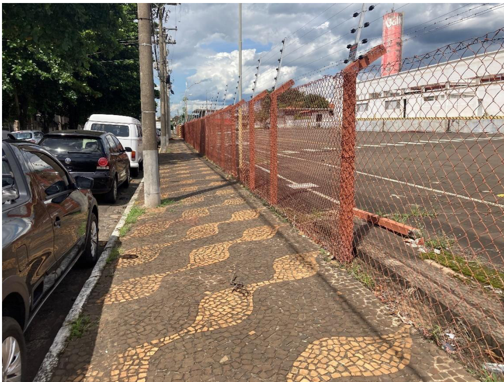
Figura 21. Vista do calçamento da Rua Timbiras.
