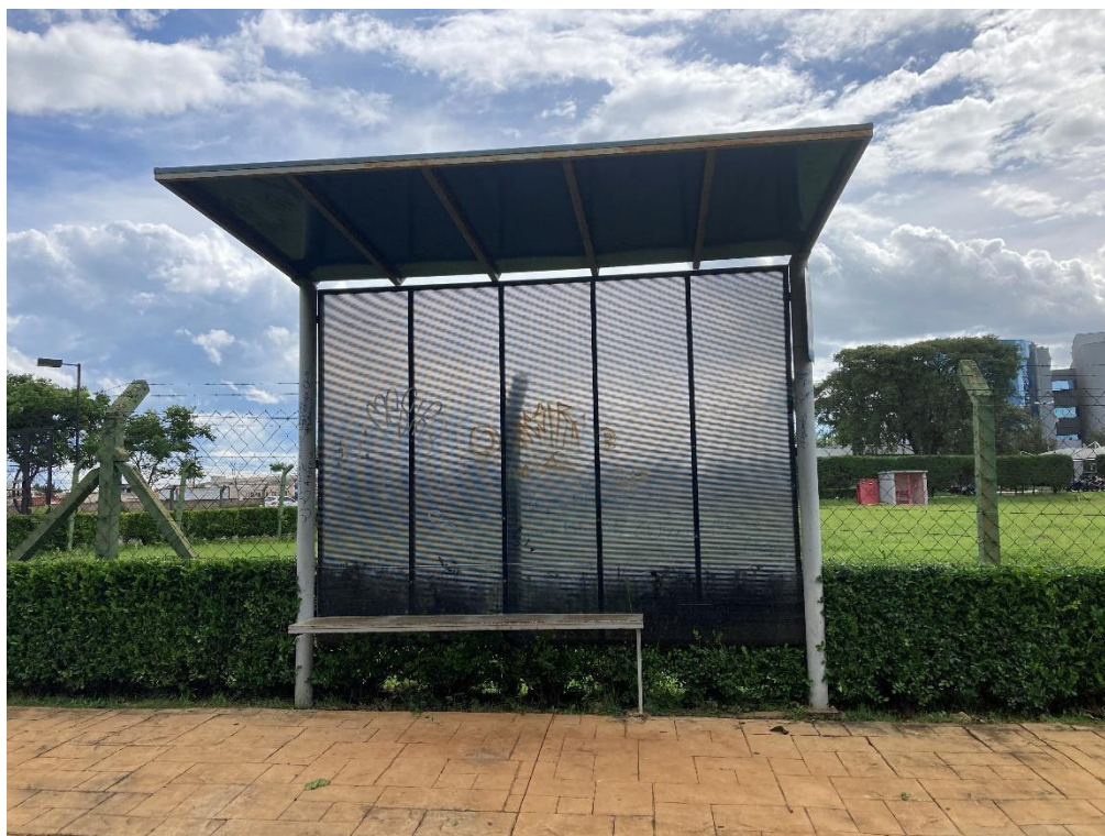
Figura 44. Ponto de ônibus localizado na Rua Turunas.
