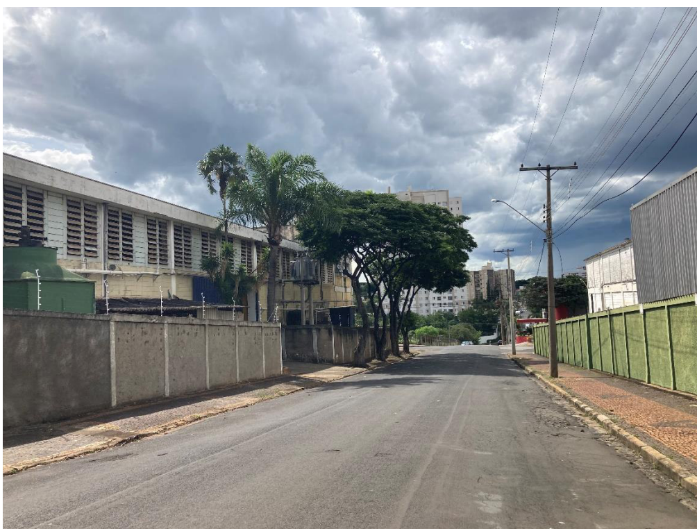
Figura 22. Vista da Rua Duque de Caxias.
