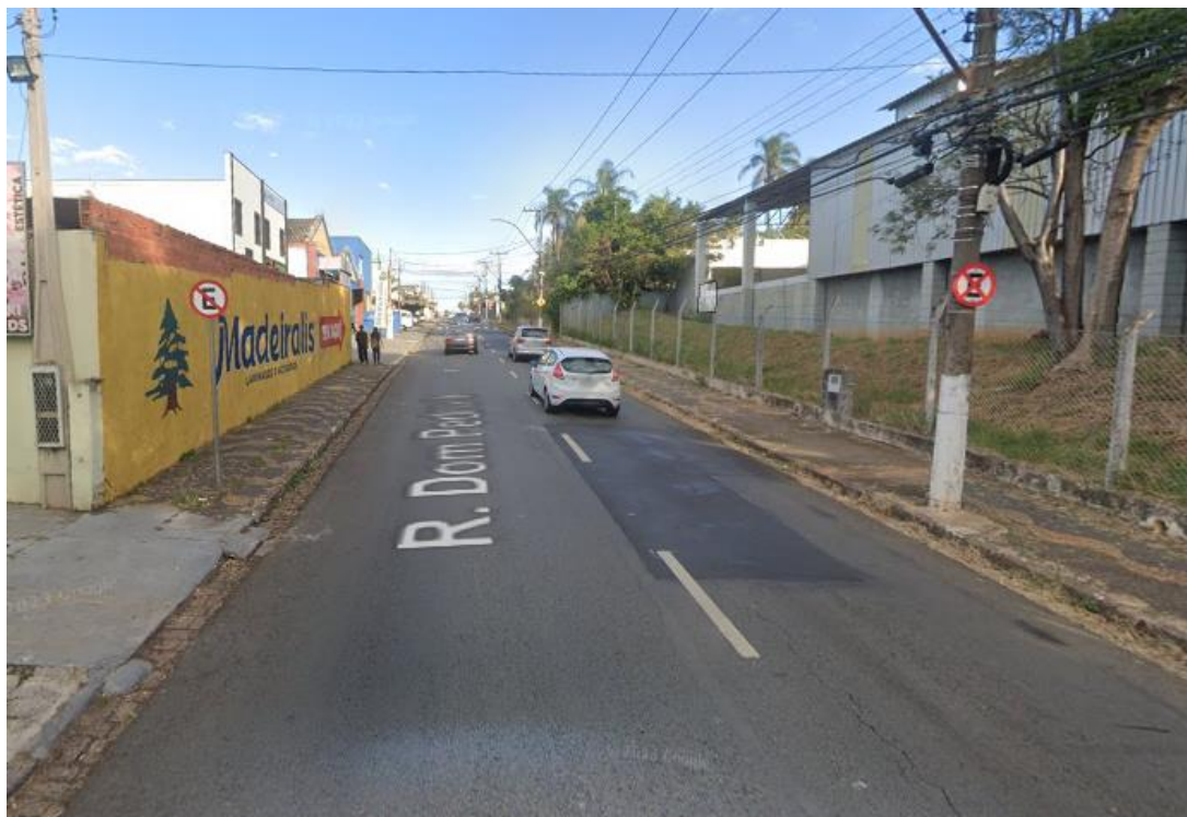
IMAGEM 26 – Rua Dom Pedro II – via adjacente ao empreendimento (Google Maps; 07/2024)
