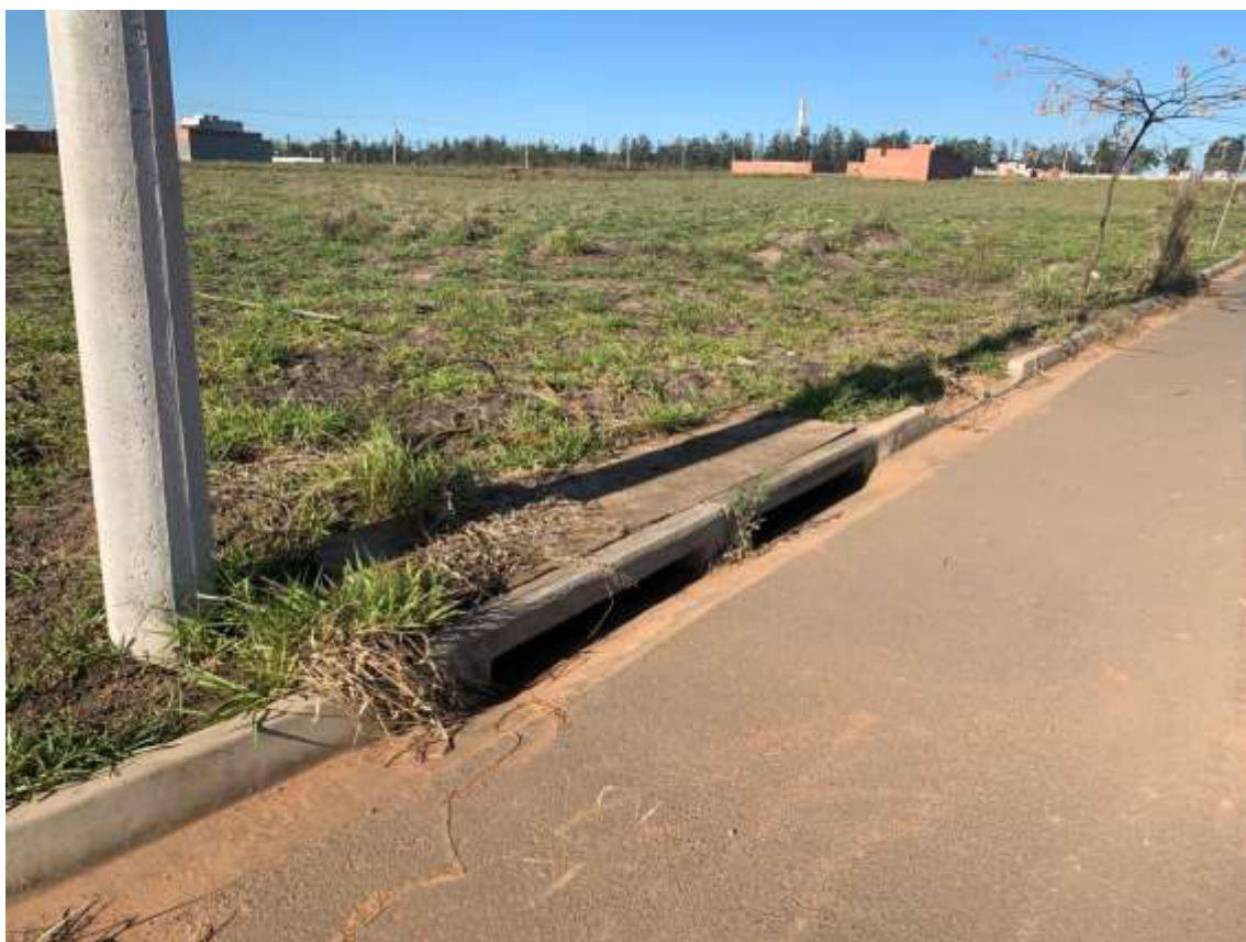
Figura 26. Boca de lobo verificada na Rua Dulcinéia Dias de Souza.
