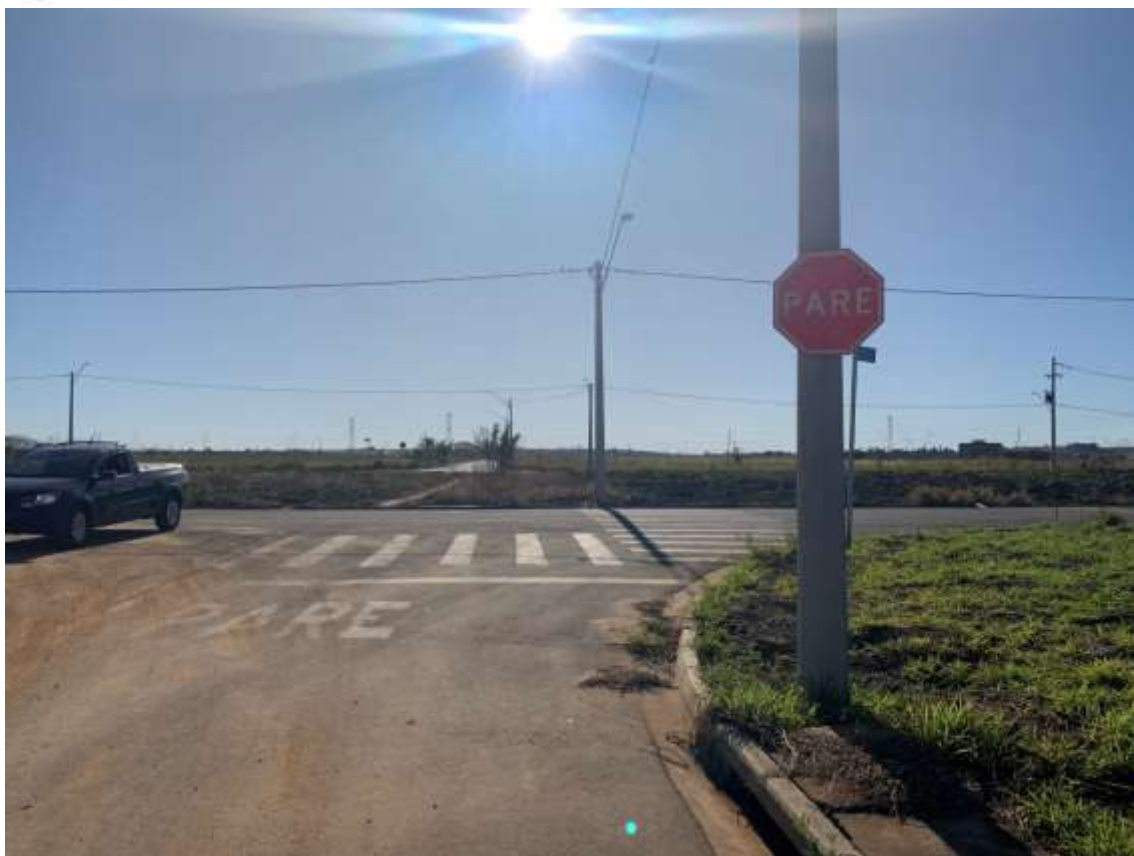
Figura 49. Sinalização na interseção da Rua Dulcinéia Dias de Souza com a Rua Oracy Alves.
