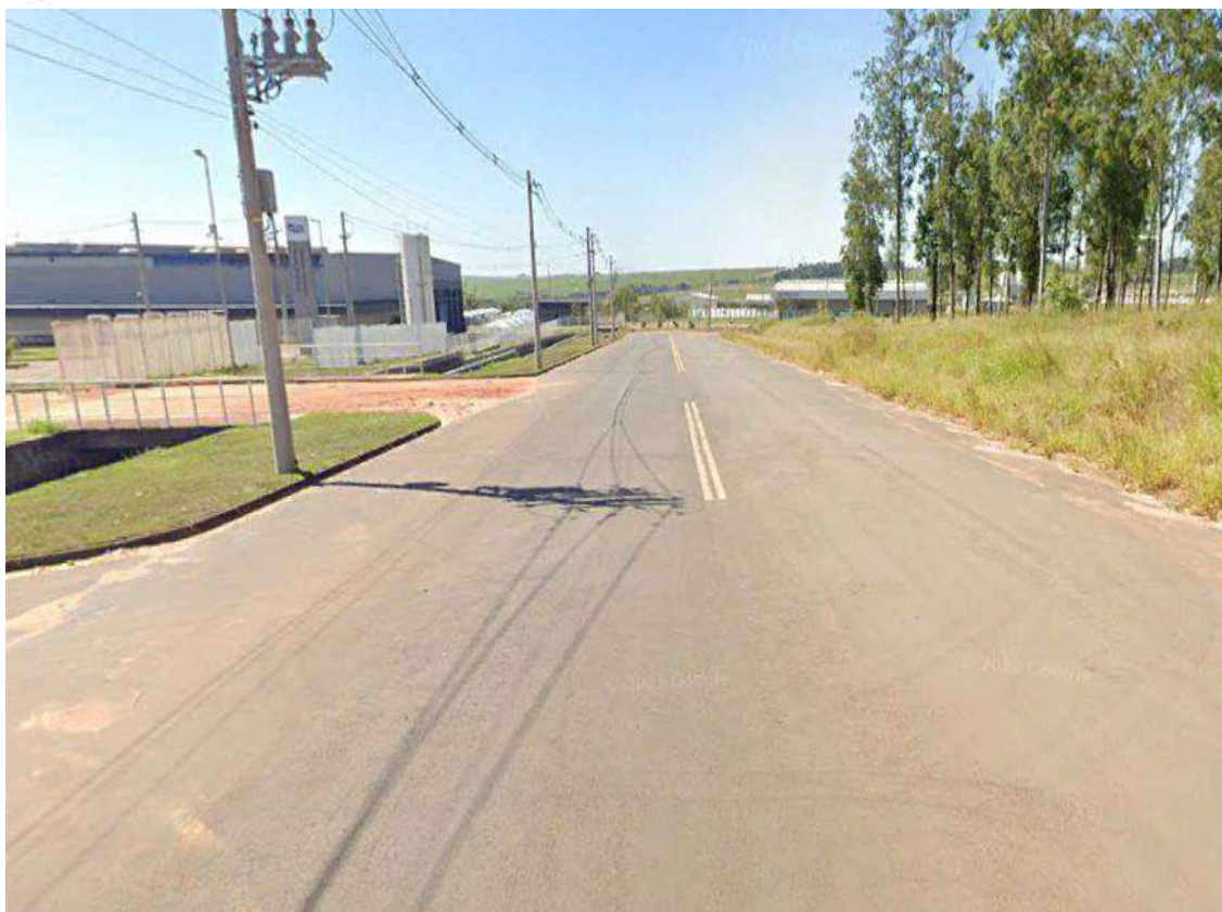
Figura 53. Vista geral da Rua Dossan trecho asfaltado.
