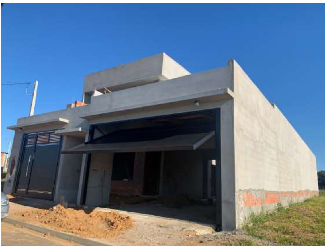
Figura 32. Residência unifamiliar sendo implantada na Rua Maria Amélia Santos Stepani.
