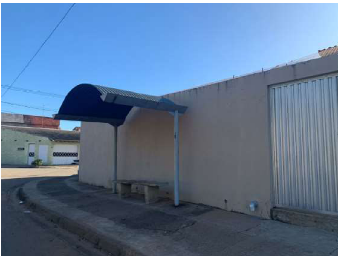
Figura 60. Ponto de ônibus localizado na Rua Cyra de Oliveira Petrin próximo ao limite da AID do Condomínio Azaleias.
