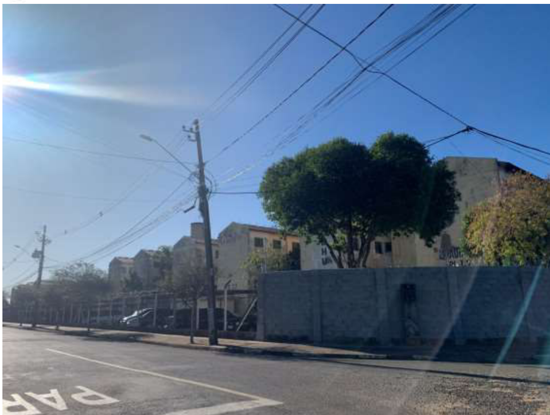
Figura 35. Condomínio residencial multifamiliar encontrado na All.
