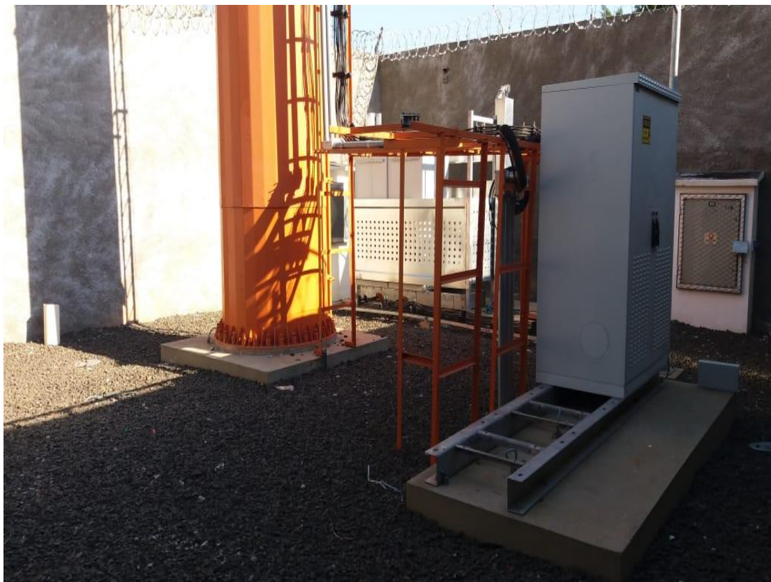
Foto 06: Área Interna da Estação (Foto Engº. Robson Silva Sobrinho)
