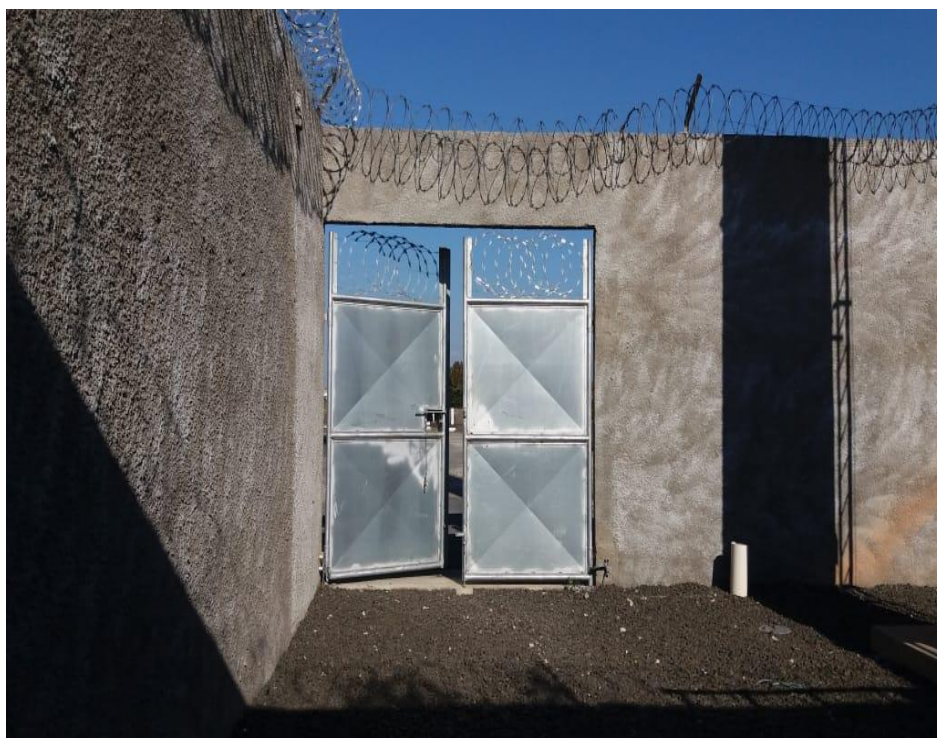
Foto 08: Local para Estacionamento de Veículos (Foto Engº. Robson Silva Sobrinho)
