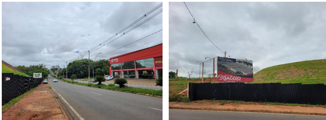
Foto 2 – Calçada do Empreendimento na Av. Nossa Senhora de Fátima
