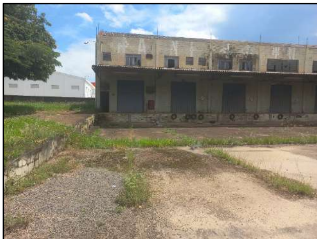
Foto 3. Galpão existente no terreno - ADA.
