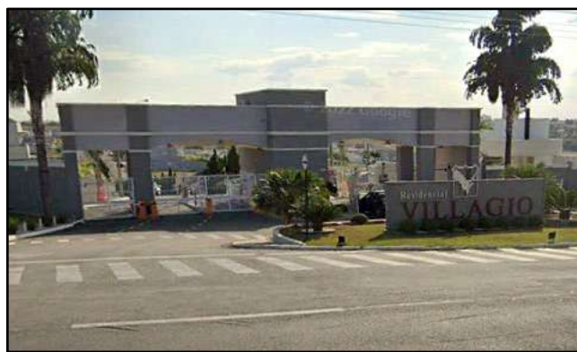
Foto 12. Condomínio residencial (Leste da AI – entorno imediato).
