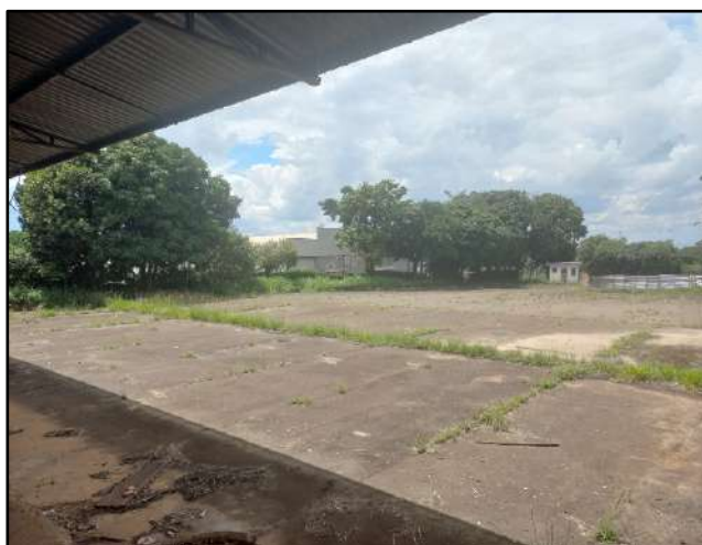
Foto 1. Trecho impermeabilizado – ADA.
