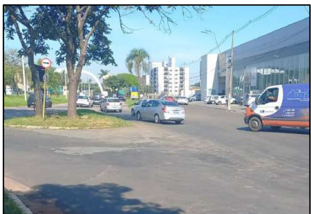
Foto 49. Vista da Rua São Gabriel (à direita) e acesso à Avenida Antônio Pinto Duarte (à esquerda).
