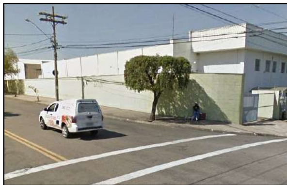
Foto 26. Centro de distribuição (Centro da AI).
