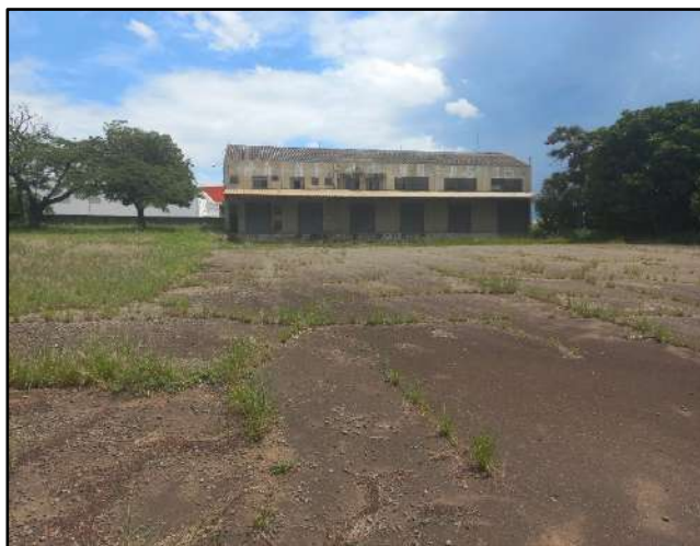
Foto 7. Vista do galpão existente – ADA.
