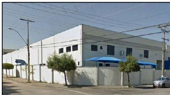
Foto 28. Galpão industrial (Centro da AI).
