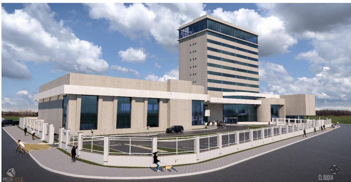
Figura 3 – Fachada frontal do empreendimento comercial Hotel Terroà
