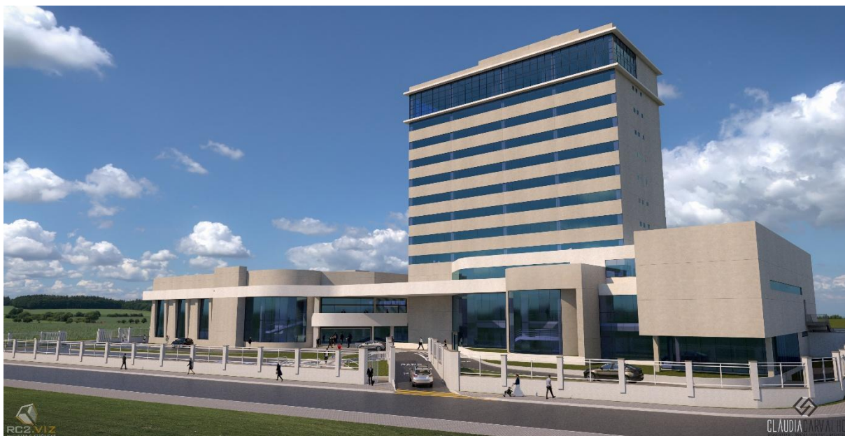
Figura 2 – Fachada frontal do empreendimento comercial Hotel Terroà
