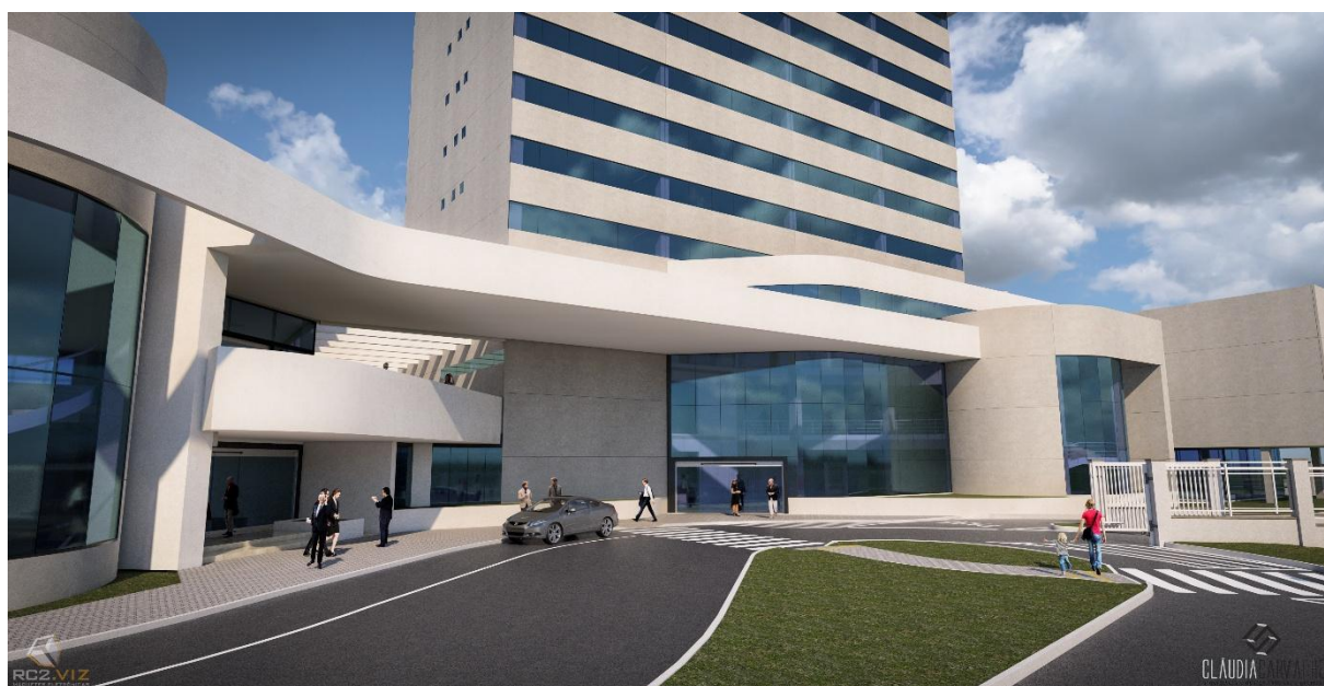
Figura 7 – Fachada frontal do empreendimento comercial Hotel Terroà
