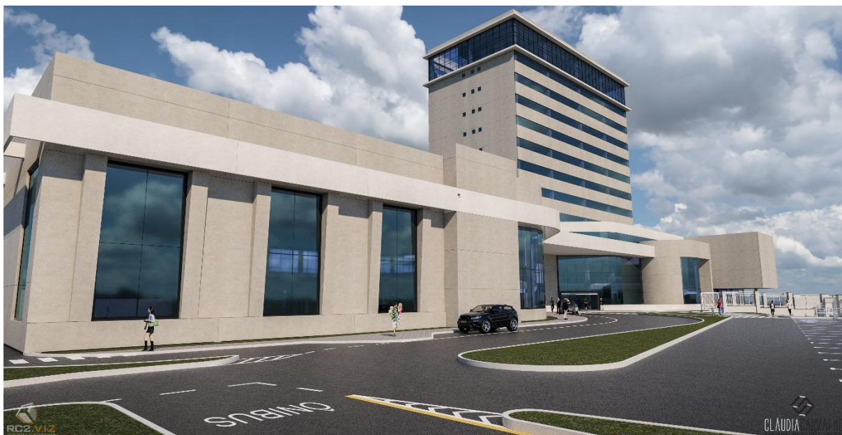
Figura 4 – Fachada frontal do empreendimento comercial Hotel Terroà
