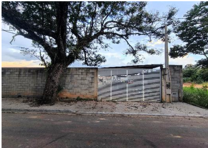
Figura 2: Vista Frontal do Imóvel.
