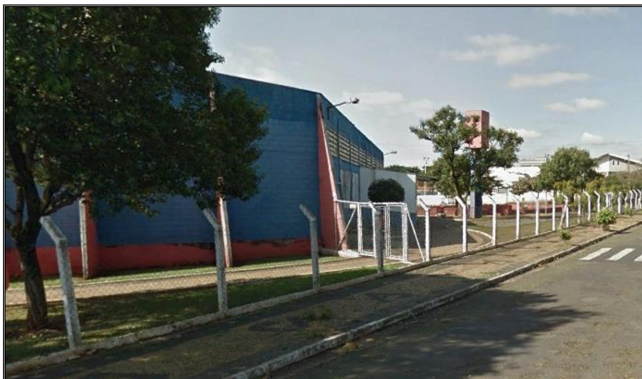
Foto 10 – Vista parcial do equipamento público de lazer, localizado a 50m.
