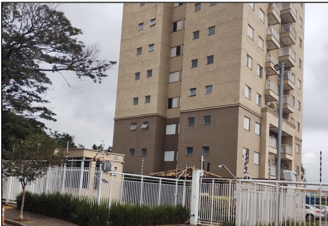
Foto 02 – Vista frontal do condomínio, com frente para a Rua Santa Ignez.
