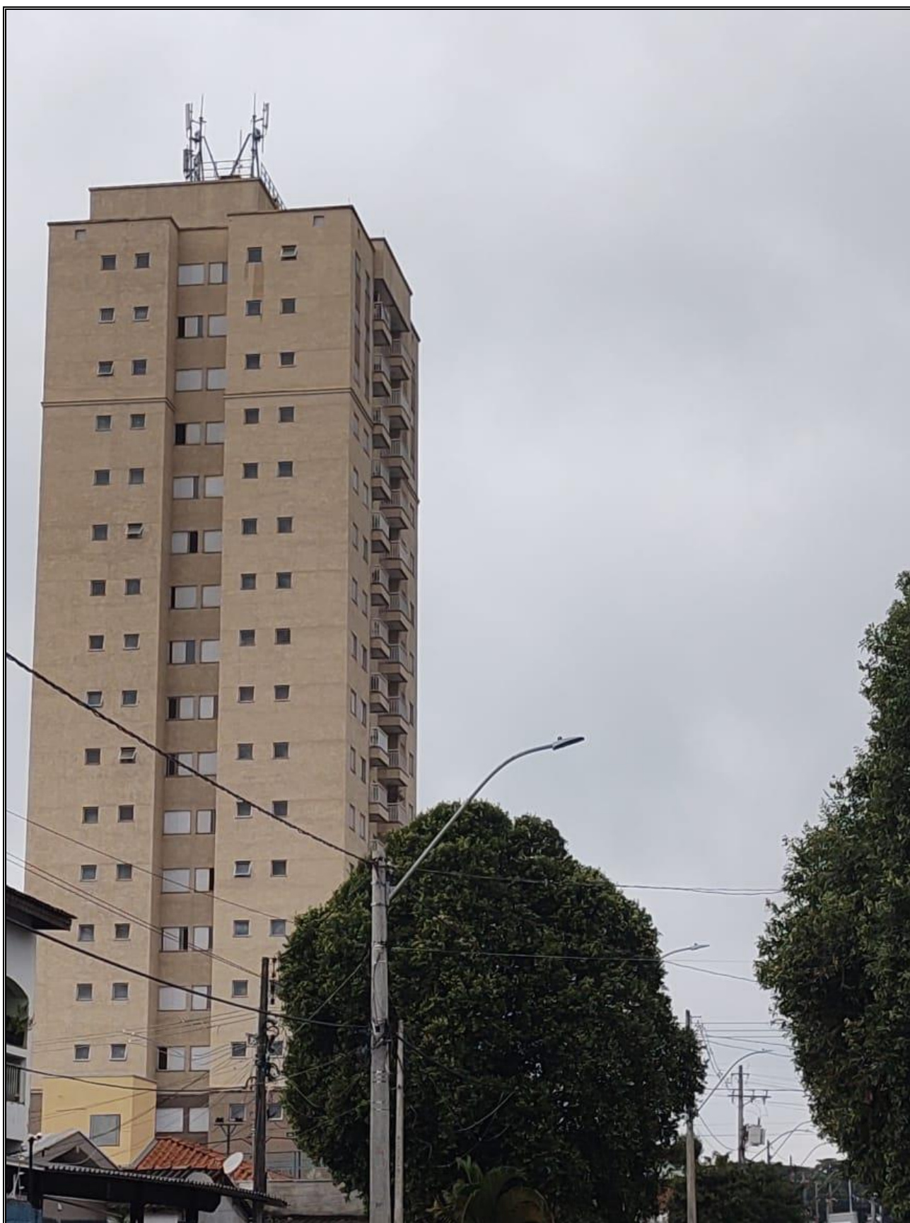
Foto 11 – Vista parcial da estação radio base no topo do edifício, a partir da Rua Santa Odila.
