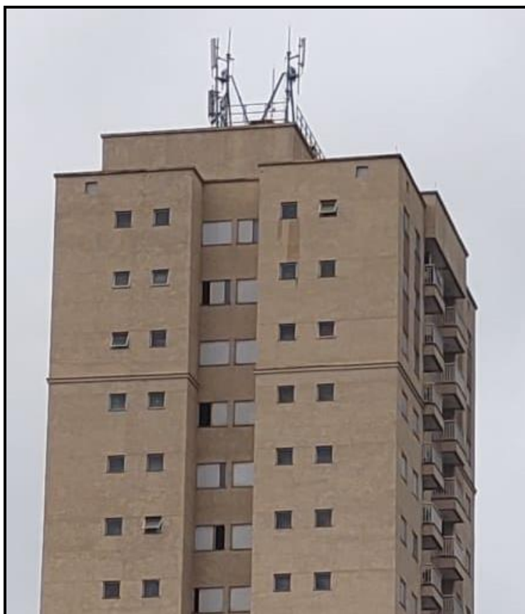
Foto 01 – ERB instalada no topo do edifício – modalidade ROOFTOP.
