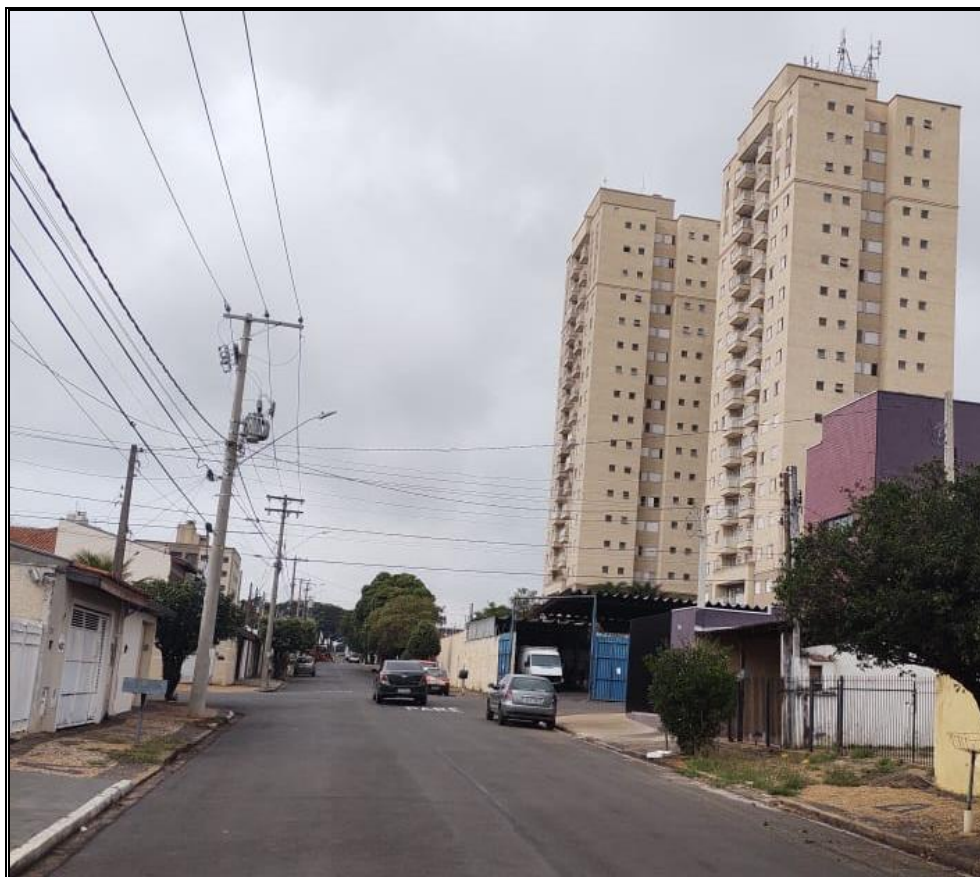
Foto 05 – Vista Parcial da Rua Santa Luzia, via lateral ao condomínio.
