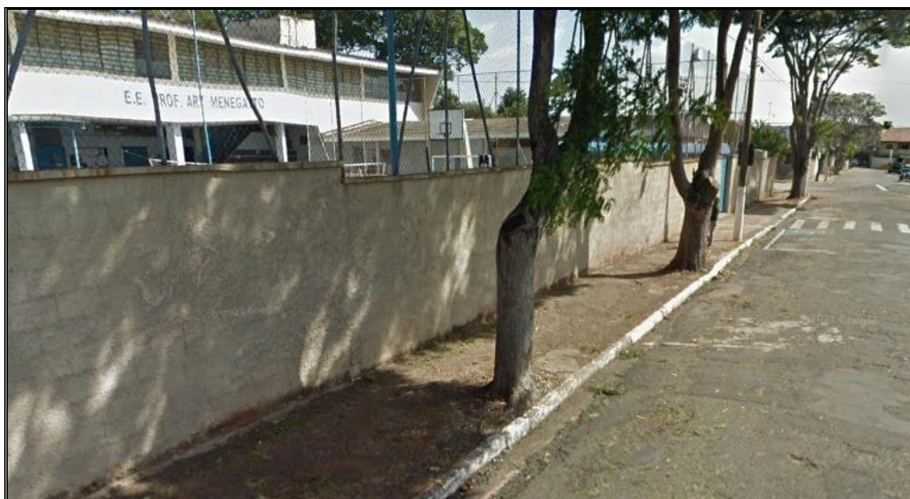
Foto 09 – Vista parcial do equipamento público de ensino existente, localizado a 150m.
