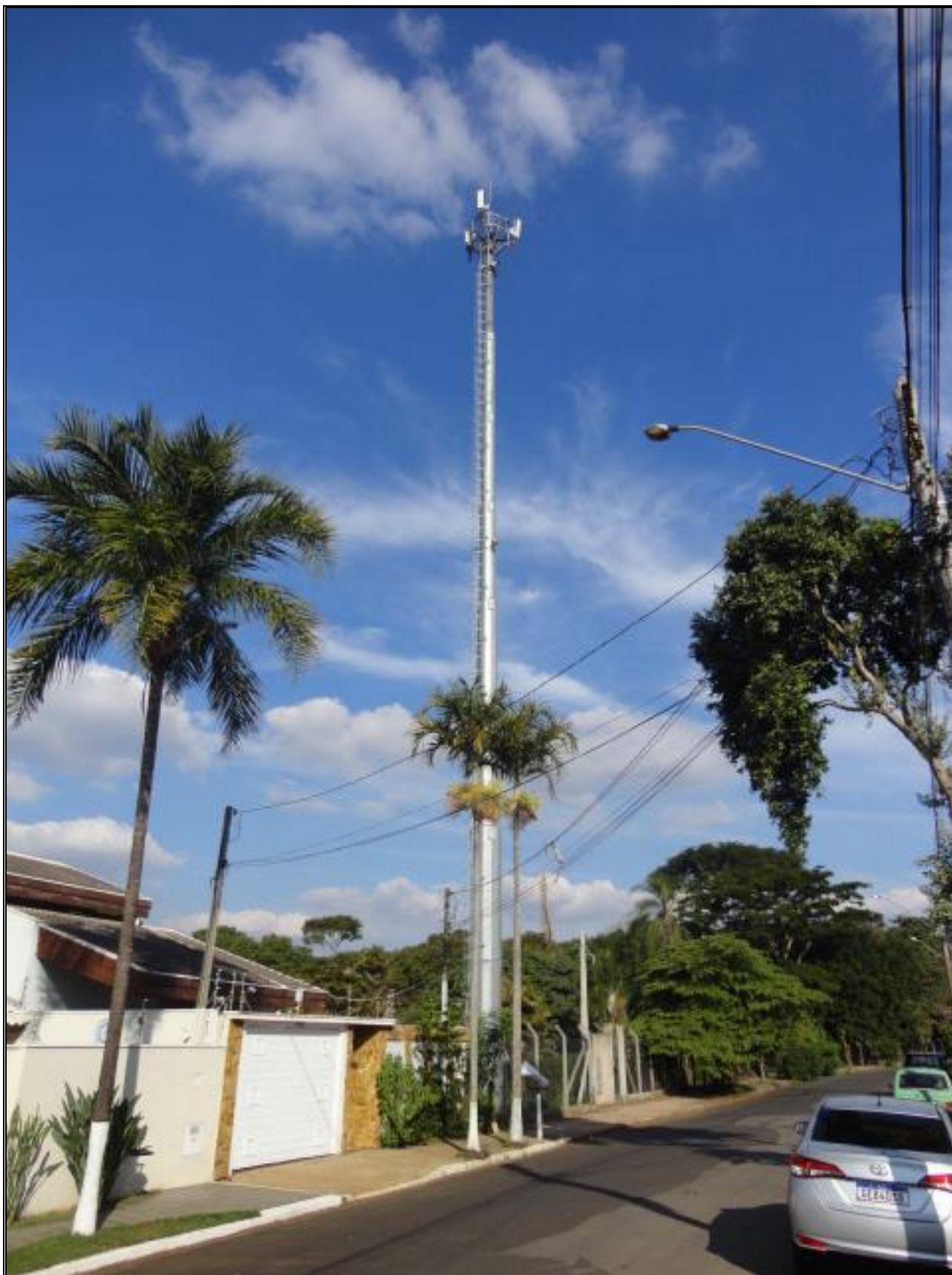
Foto 11 – Vista da estrutura vertical e das edificações da vizinhança, a partir da Rua Itabirito.
