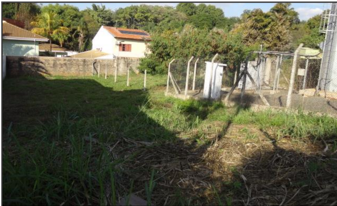
Foto 03 – Vista parcial dos equipamentos que compõem a ERB e da área remanescente do terreno ao fundo.
