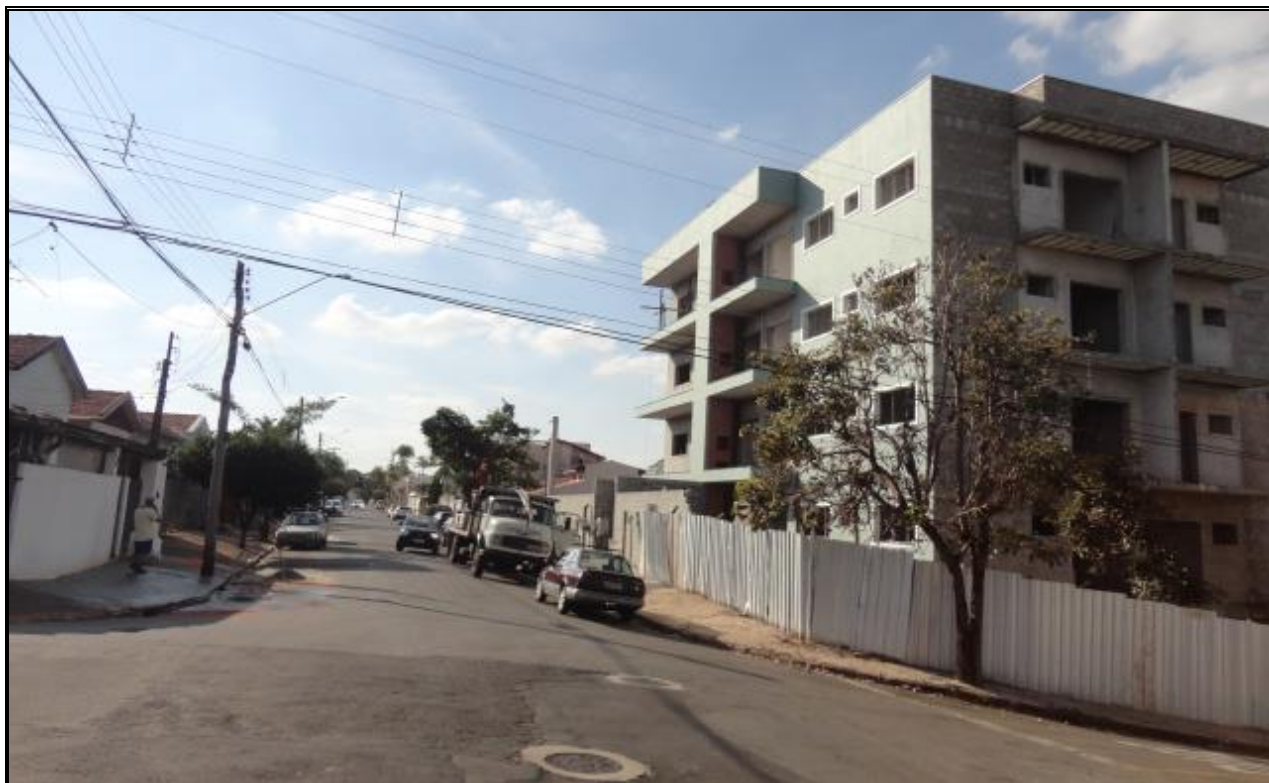
Foto 04 – Prédios em construção para fins residenciais, localizado na Rua Itabirito, a aproximadamente 60m do empreendimento.
