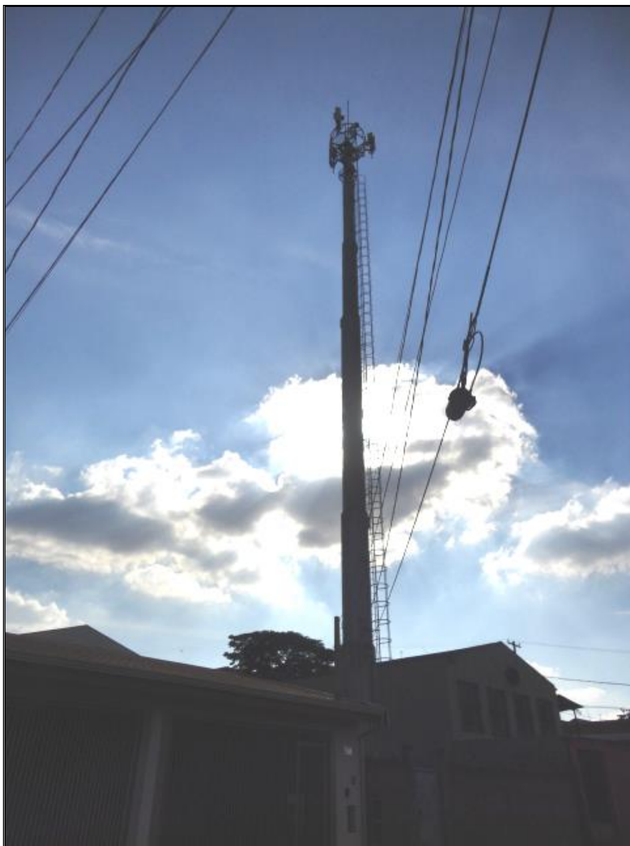
Foto 11 – Vista da estrutura vertical e das edificações da vizinhança, a partir da Rua do Botafogo.
