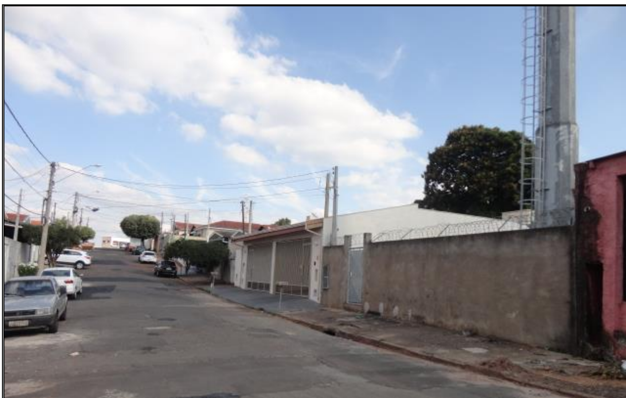
Foto 13 – Vista parcial da Rua do Botafogo, com fachada da estação a direita.
