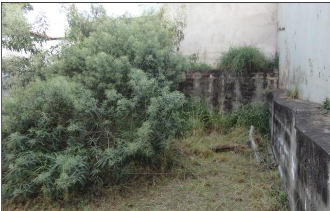
Foto 10 – Detalhe da área remanescente locada do terreno nos fundos.
