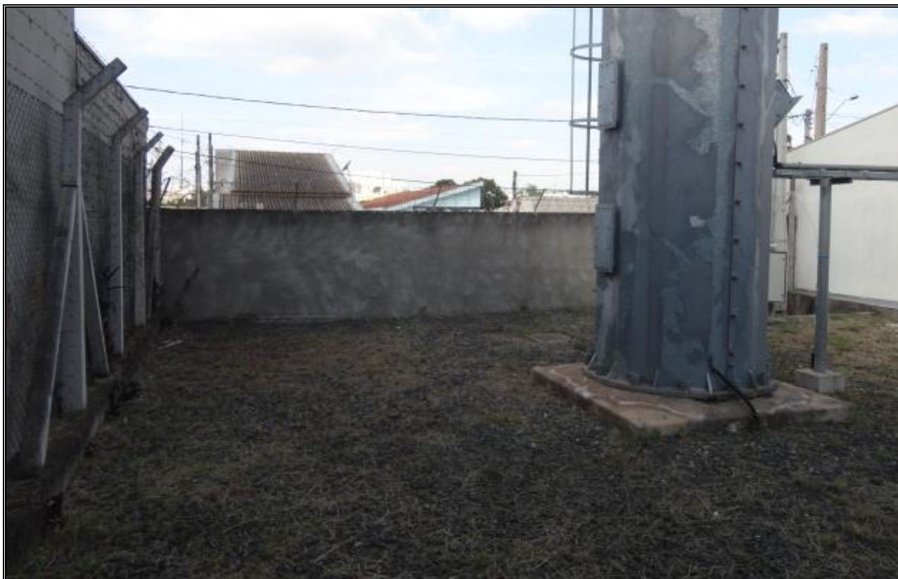
Foto 02 – Vista parcial do interior da ERB, com estrutura vertical e área permeável com pedra britada.
