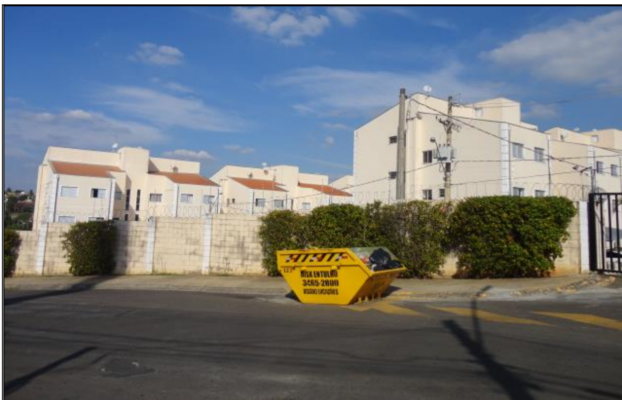
Foto 13 – Vista parcial da Avenida Antônio Centurione Bôer, com condomínio habitacional ao fundo.
