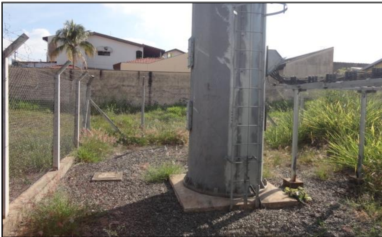
Foto 02 – Vista parcial do interior da ERB, com estrutura vertical e área remanescente do terreno.
