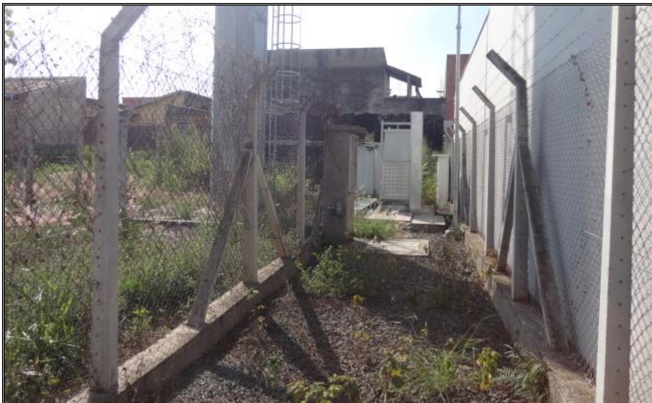
Foto 09 – Vista parcial da área de implantação da ERB e área remanescente do terreno locado, devidamente cercada para garantir a segurança da vizinhança imediata.
