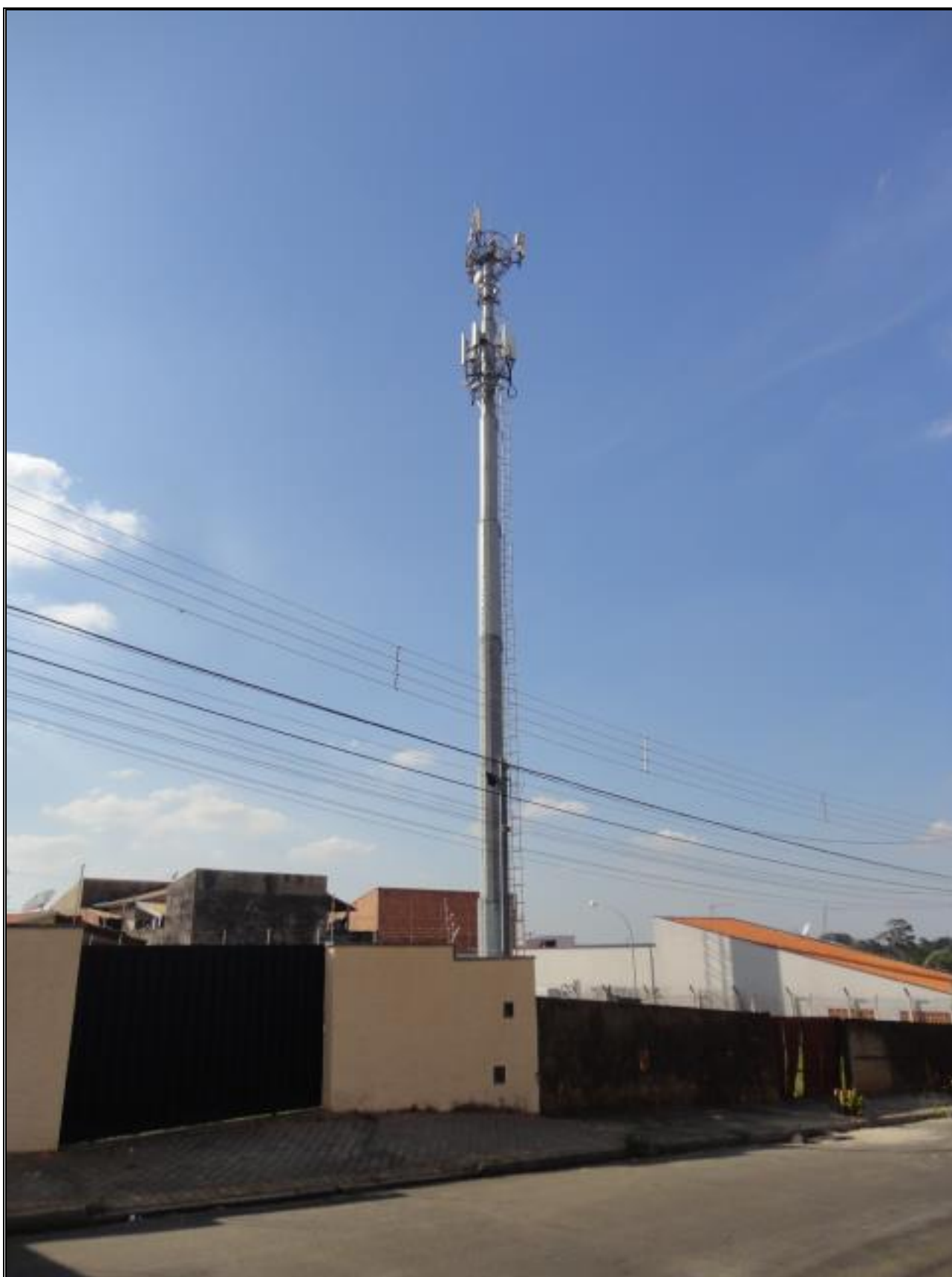
Foto 11 – Vista da estrutura vertical e das edificações da vizinhança, a partir da Avenida Antônio Centurione Bôer.
