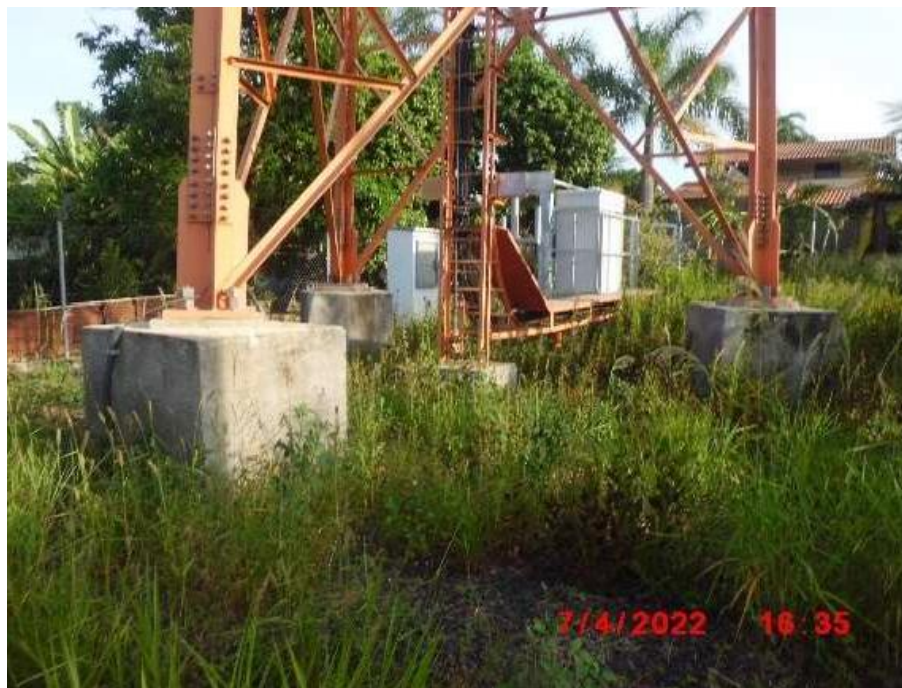
Foto 6.6-5: Área interna - instalações.
