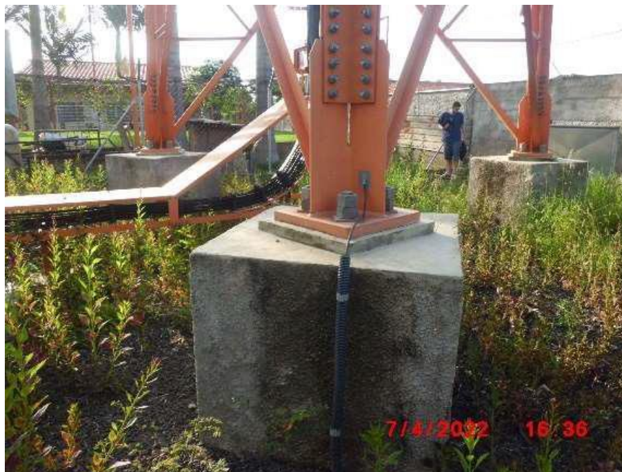
Foto 6.6-11: Área interna: base da torre.
