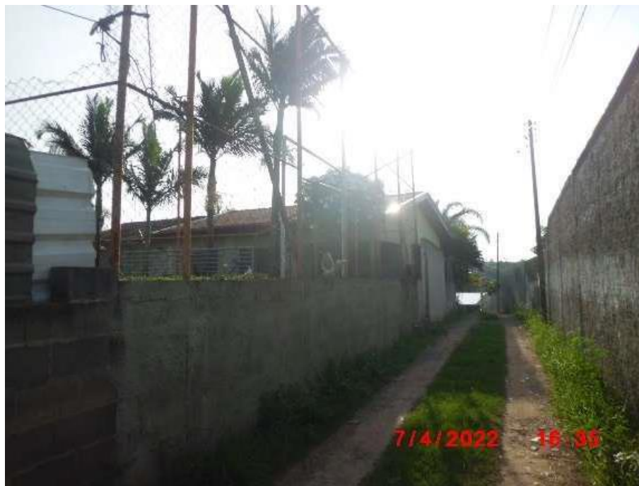
Foto 6.6-3: Vista do acesso – área de servidão.
