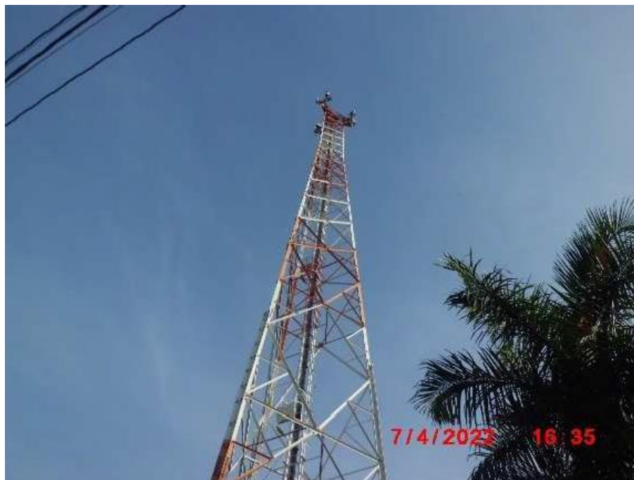
Foto 6.6-9: Vista da torre.
