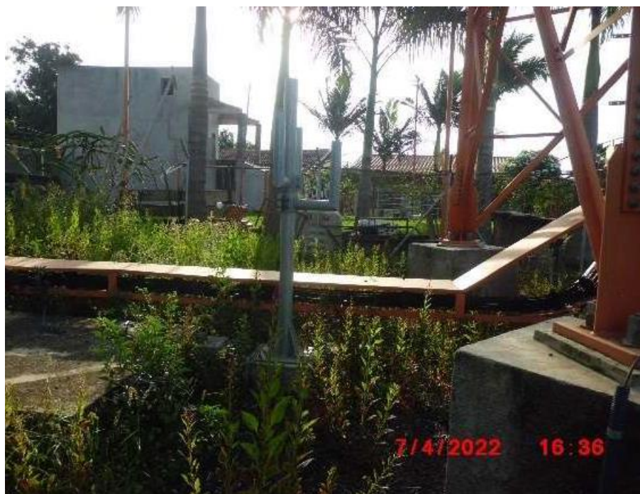
Foto 6.6-12: Área interna: instalações.
