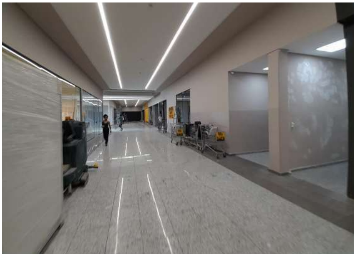
Figura 10. Vista do local onde serão construídas as lojas.
