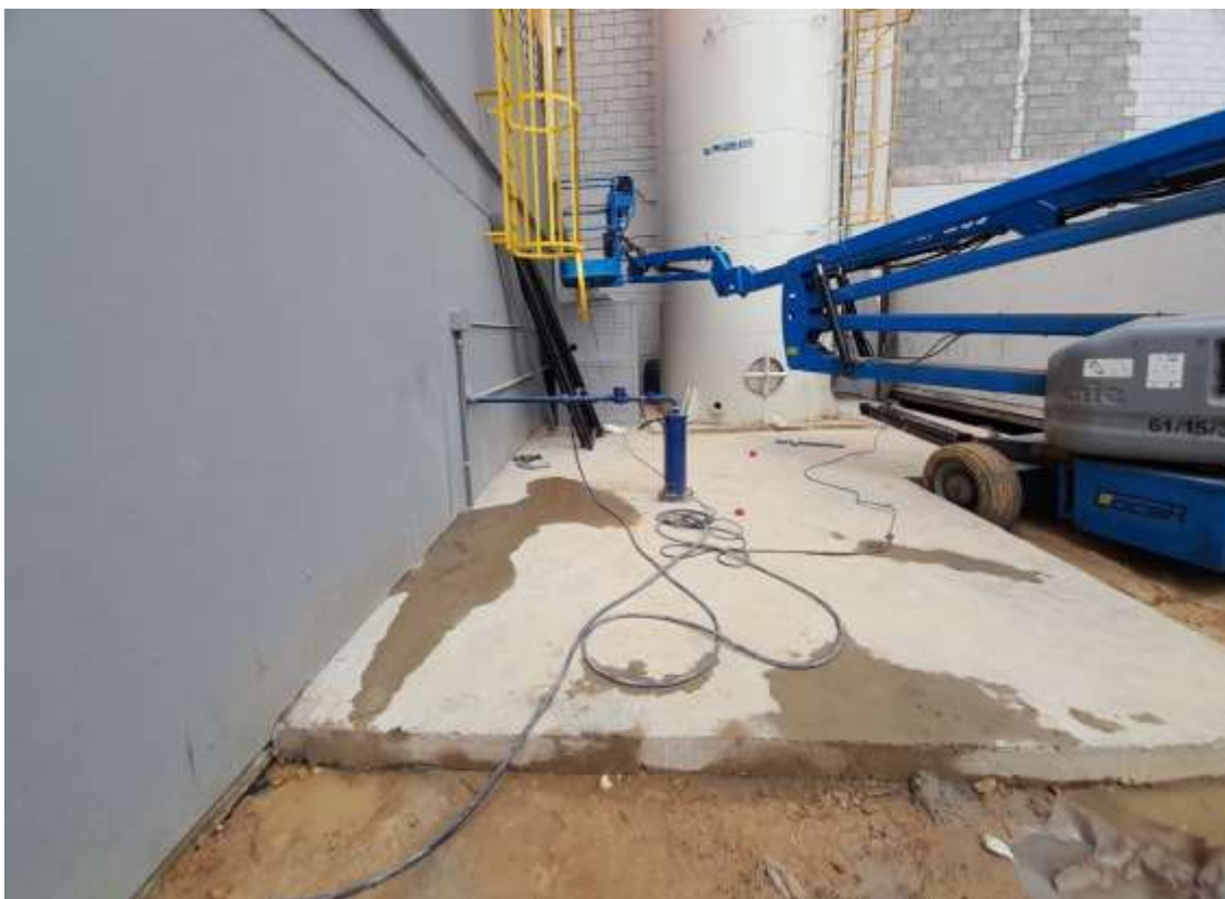
Figura 12. Vista do poço artesiano que abastece a área de estudo.
