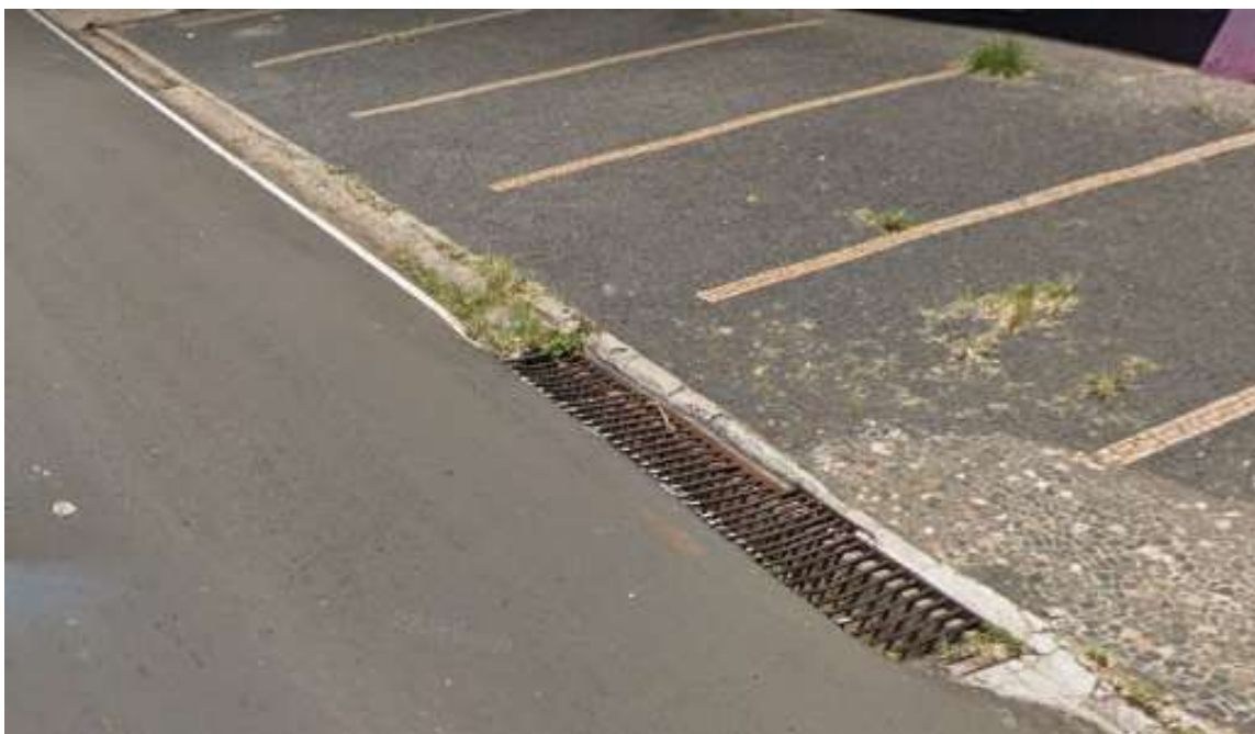
Figura 28. Boca de lobo na Av. São Jerônimo.
