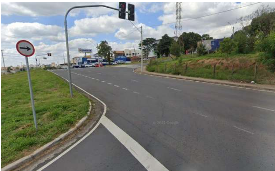
Figura 32. Vista geral da Avenida Europa.
