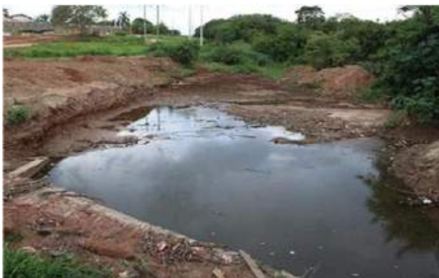
Assoreamento no Córrego Barroca.
